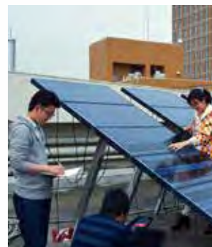
太陽光発電システムの診断風景
